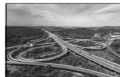
D. 修立交桥
