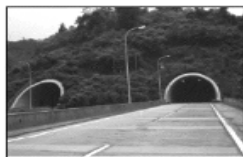
B. 开凿隧道
